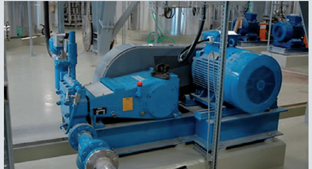
ABEL Série HP pour le nettoyage des toiles filtrantes sur les filtres-presses
