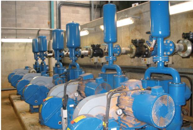
Pompes à pistons et membranes CM dans une installation de traitement des eaux en Irlande du Nord
